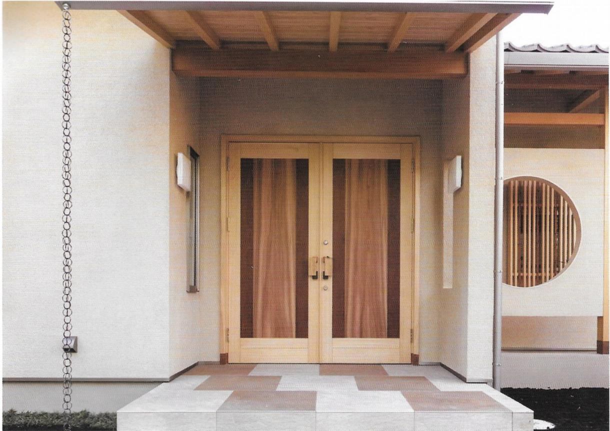
正面玄関のドアの面材は秋田杉とホンデュラスマホガニーを組み合わせた ドア枠の下部には腐食防止用の銅板
