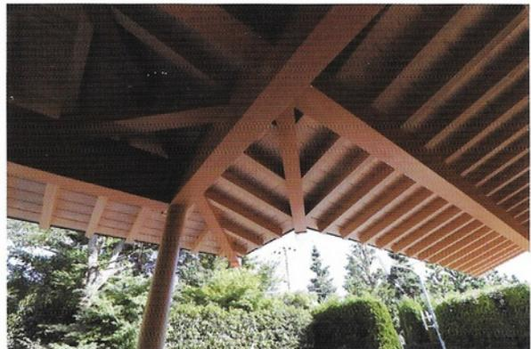
化粧軒裏屋根を磨丸太の独立柱で支えている
