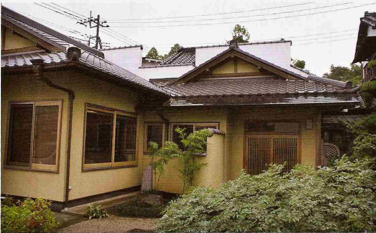
素材は桧で1500×2700mmの2枚立て。重さは約45kg。一枚が1500×900mmで複層ガラスが入っている。軒の出は約80cm
