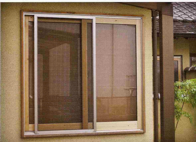
アルミ枠を使って木製サッシを設置 玄関や枠との変色差は一目瞭然
