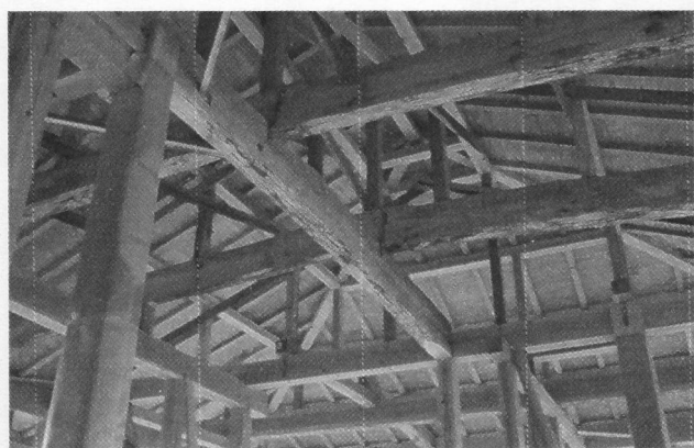
背割り材を使った躯体
