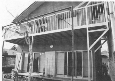
守谷宅のリフォームでは、外回りに無垢材を用いて耐久性を検証中
