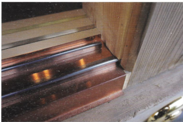
レールは通常6～7mmのところを12mmとし、触媒効果を出すために銅板を巻いた
