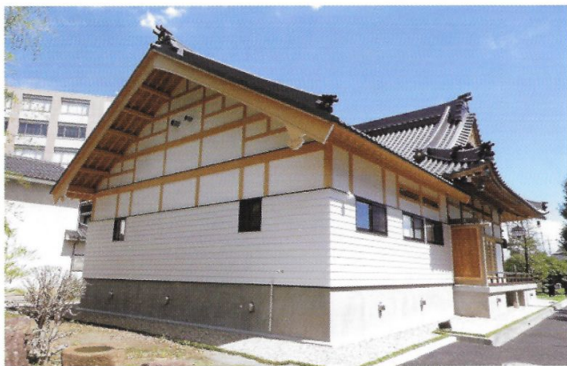
寺院裏手から増築部を見る
