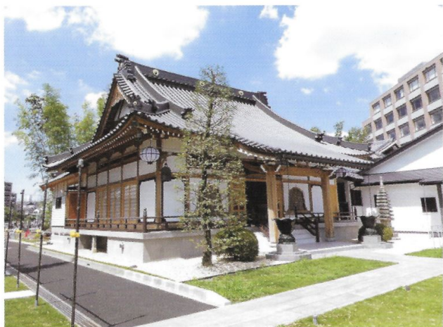
完成した不動院
