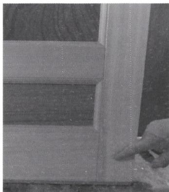
下枠に水抜き用の穴をあける
